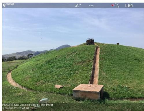
**Figura 34: Aterro com resíduos cobertos, sistema de drenagem e exaustão de gases**
