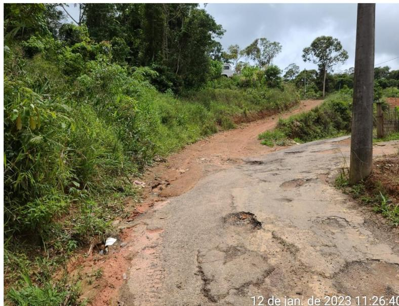
**Figura 13: Via sem Passeio Público, com Pavimentação Precária e sem Dispositivos de Drenagem - com Processos Erosivos**
