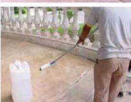
Aplicação de resina após execução de corte de junta de controle e lavagem
