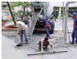
Descarga, espalhamento e nivelamento da base de concreto (sarrafeamento)
